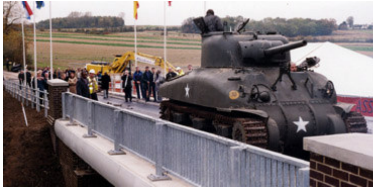
Figura 2.14: Ponte West Mill na Inglaterra, (FiberLine, 2004).
