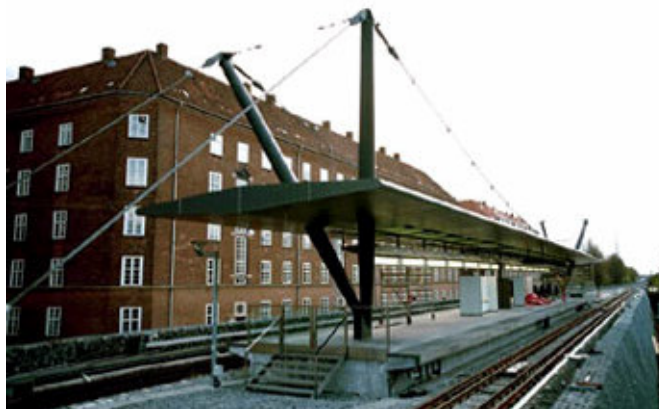
Figura 2.16: Estação de metrô na Alemanha, (Fiberline, 2004).
