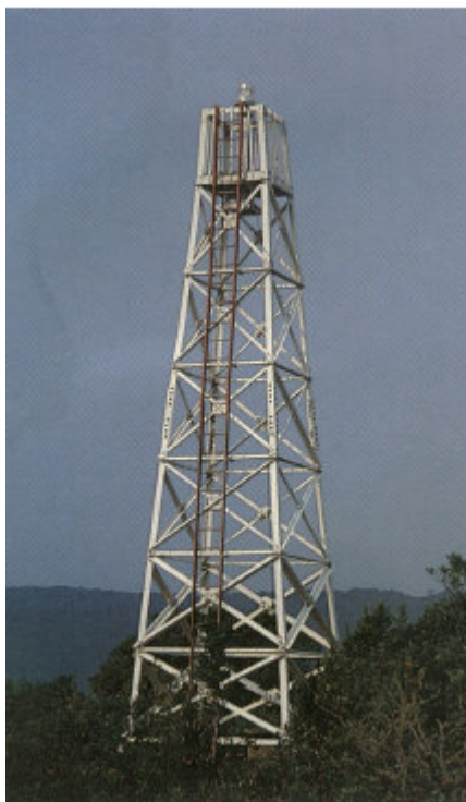
Figura 2.19: Vista da torre de sinalização da Marinha do Brasil, (Euzébio, 2004).
