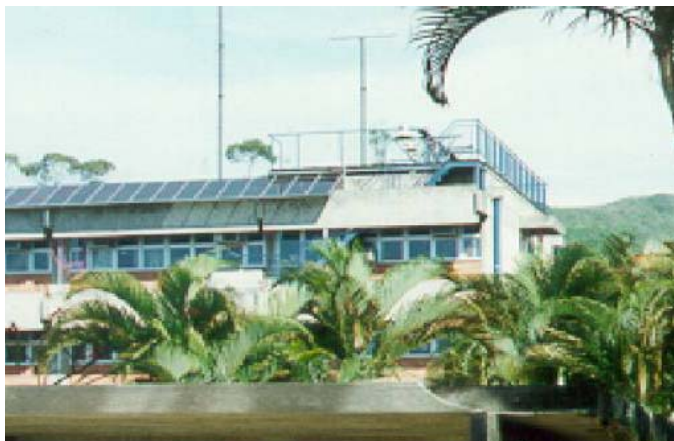
Figura 35. Local das medições (Bloco A do Departamento de Engenharia Mecânica da UFSC).
