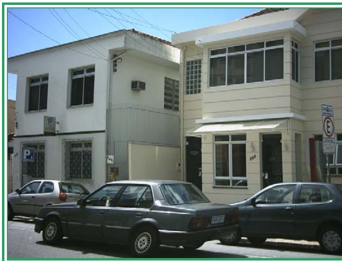
Figura 15 – Antigas residências unifamiliares atualmente destinadas à prestação de serviços.
