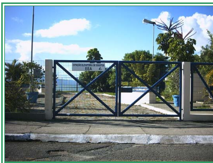
Figura 25 – Área do sistema de saneamento da Av. Beira Mar Norte.
