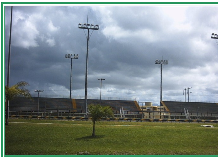
Figura 20 – Área institucional – Passarela do Samba.
