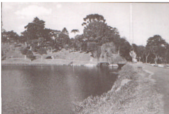
Figura 22– barragem do São Lourenço no rio Belém. Destaque para o fundo de vale inundado e as declividades acentuadas ao fundo cobertas por bosques nativos remanescente de Araucárias. Vista do lago para controle de vazão, ausência de matas ciliares e no canto direito a represa camuflada por taludes, grama e ponte. Fonte: foto in IPPUC (1990)
