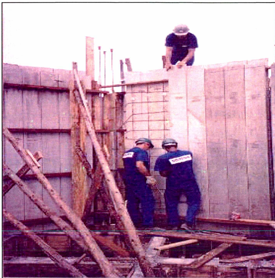
Figura 27: Colocação dos painéis pré-moldados da cortina
