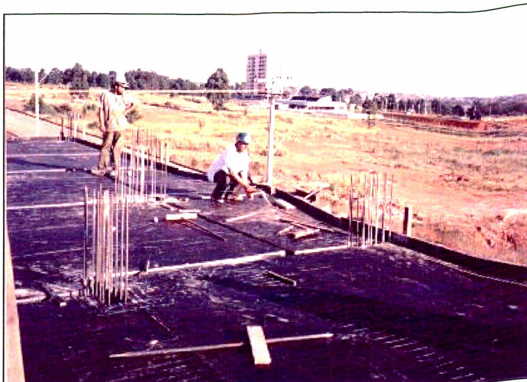
Figura 20: Conferência das fôrmas da laje
