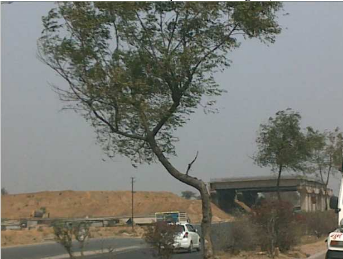
Figura11 – Uma das obras rodoviárias (próximo a Gurgaon).
