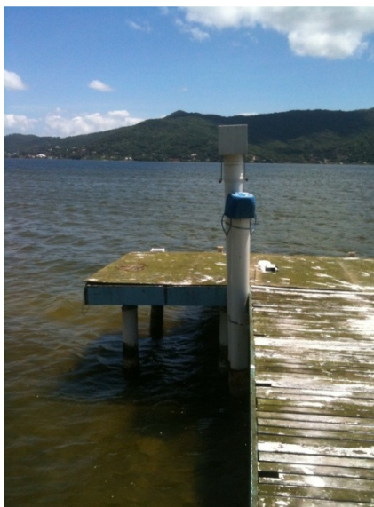
Figura 17: Ponto de instalação do Digilevel.
