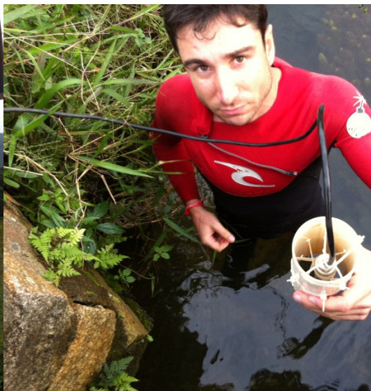
Figura 13: Instalação do sensor de pressão.
