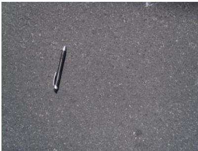
Figura 5.24 - Textura do revestimento com Asfalto-Borracha (após a restauração).
