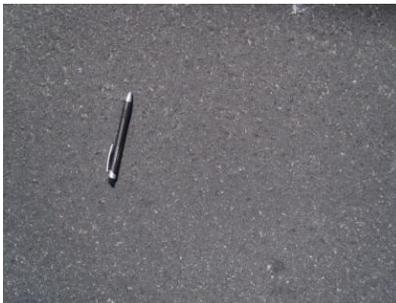
Figura 5.7 - Textura da superfície com mistura Asfalto-Borracha (segmento já restaurado).
