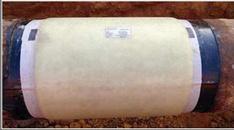
Figura 6: Residuto® - Luva de material compósito, indicado para reparo de dutos por corrosão ou moessa (RUST ENGENHARIA, 2011).
