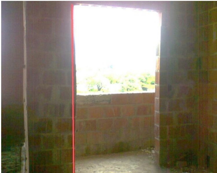
Figura 30: Alvenaria inadequada quesito prumo em abertura de porta.
