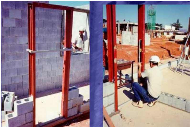
Figura 17: Colocação de batentes metálicos
