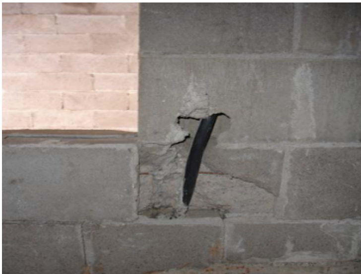
Figura 24: Quebra de contra-verga para passagem de tubulação elétrica. Fonte: Alexandre (2008).
