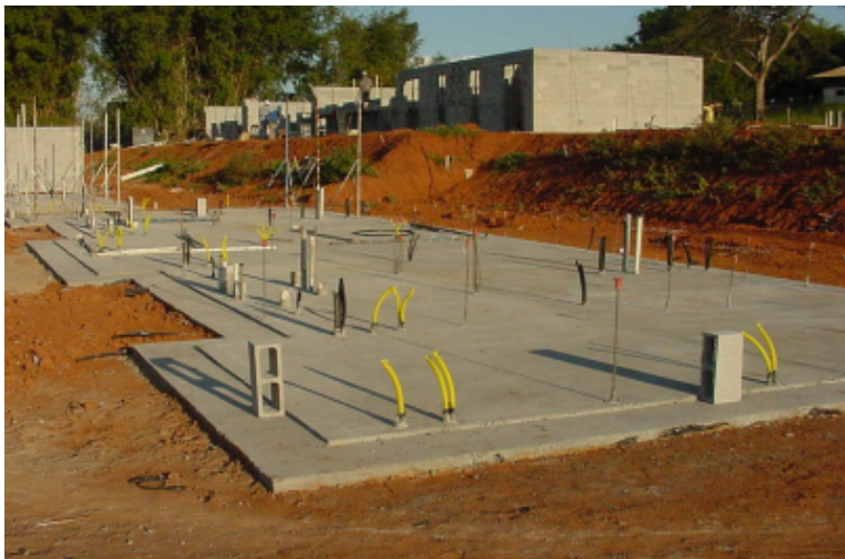
Figura 13: Fundação e locação de instalações.
