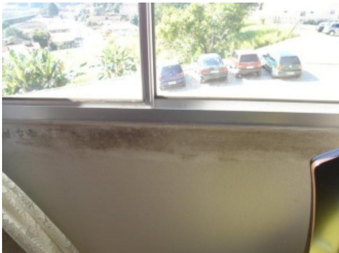
Figura 27: Mancha de umidade causada por infiltração no peitoril. Fonte: Adaptada de ANTUNES (2011).
