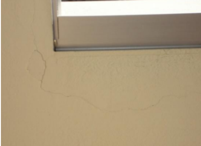
Figura 28: Fissura peitoril da parede interna. Fonte: Adaptada de ANTUNES (2011).
