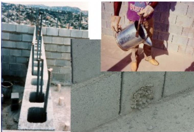
Figura 19: Grauteamento do primeiro lance.
