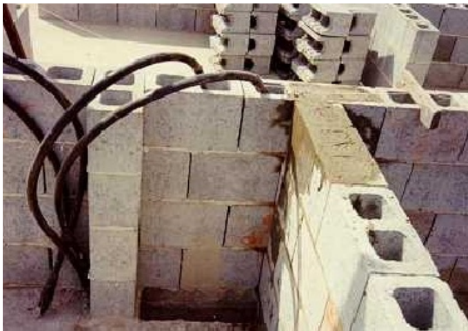
Figura 15: Passagem de tubulação.
