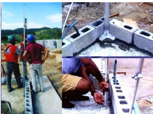
Figura 16: Posicionamento de escantilhões e blocos para elevação das paredes.
