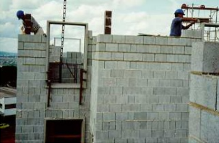
Figura 20: Exemplo de elevação das paredes.
