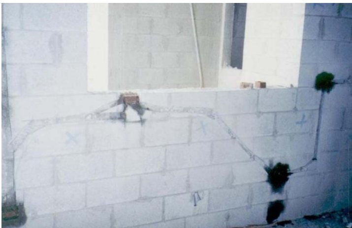
Figura 25: Prática inaceitável se tratando de alvenaria estrutural, e ainda existente, de rasgos horizontais nas paredes para execução de instalações. Fonte: SANTOS (1998).
