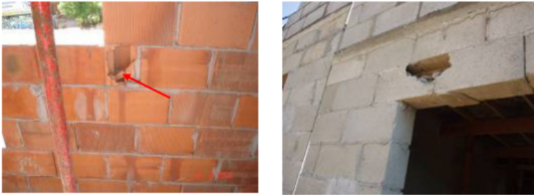
Figura 23: Transpasse insuficiente para dentro das paredes Fonte: Alexandre (2008).
