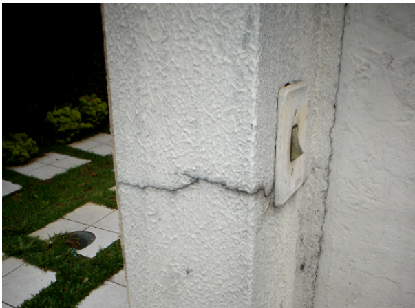
Figura 26: Fissura no interruptor da campainha. Fonte: CANO (2005).
