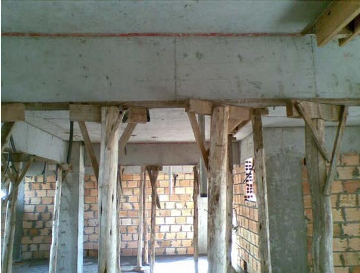
Figura 9 - Estrutura de pavimento com lajes maciças apoiadas em vigas
