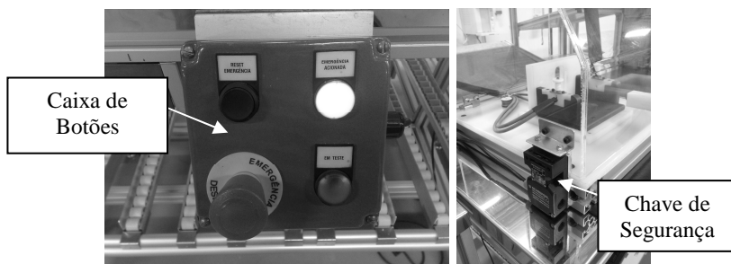
Figura 66 - Equipamentos do módulo de controle instalados na cabine de testes Fonte: Autor (2012).
