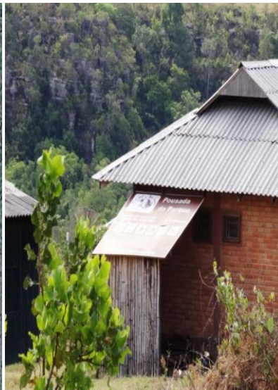
b) Uso indevido de placas de sinalização 15°26'41,98''S / 55°49'28,90'' O
