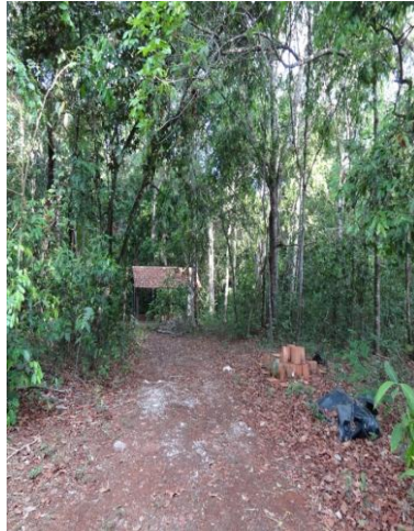
(6) Invasão com construção irregular
