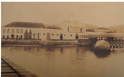
Figura 12: Casa Hoepcke 40 ao fundo, a Alfândega 41 e o trapiche municipal (1890).
