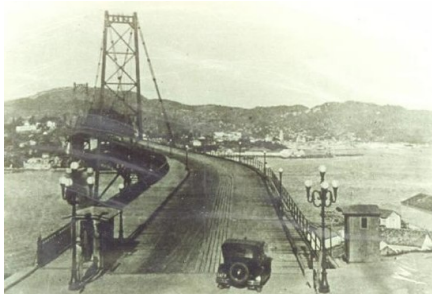
Figura 21: Ponte Hercílio Luz – década de 1930.
