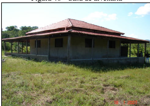
Figura 40 - Casa de alvenaria
