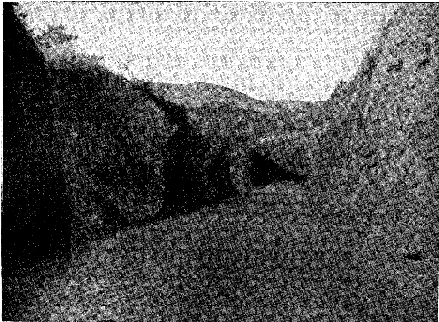
ESTRADA CURITIBA—JACARÊZINHO (Trecho em construção)
