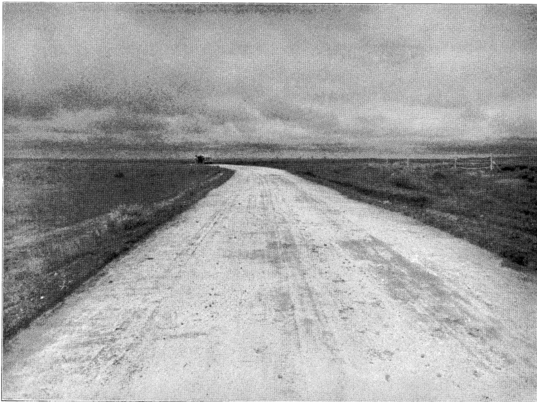
ESTRADA CURITIBA — PONTA GROSSA (Pedregulhamento)
