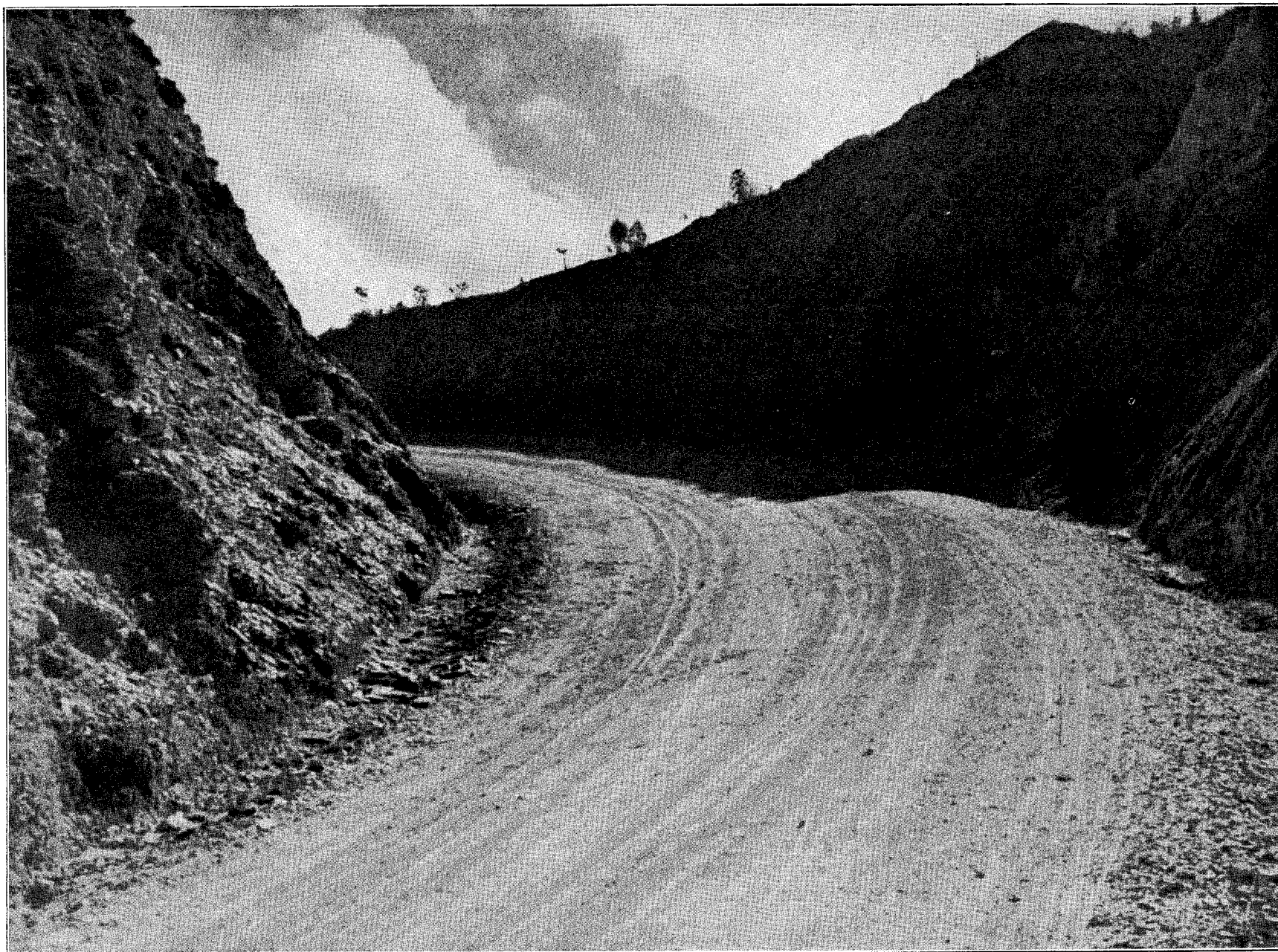
ESTRADA CURITIBA—JACARÈZINHO (Trecho em construção)
