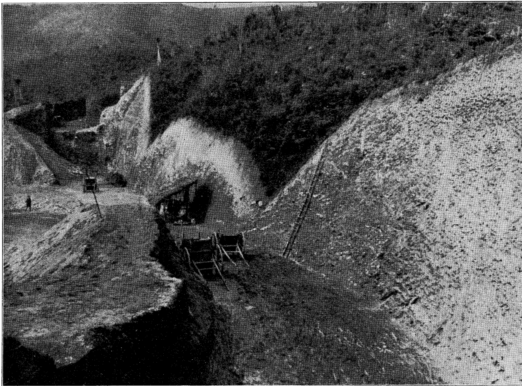
ESTRADA DE CURITIBA—JACARÉZINHO (Trecho em construção)
