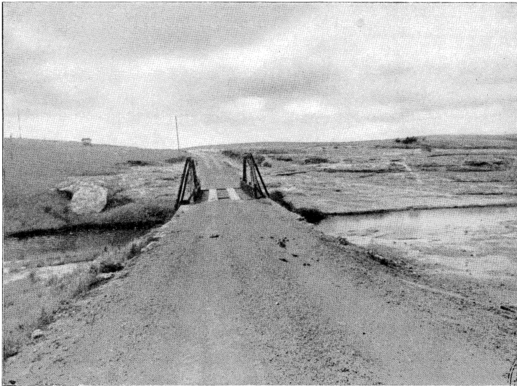
ESTRADA CURITIBA—PALMEIRA. Trecho pavimentado a macadam
