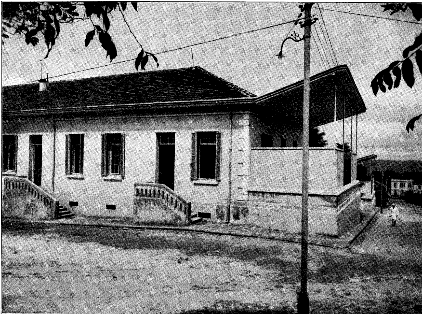
Galeria de cura para tuberculosos (Sanatório São Sebastião) - Lapa
