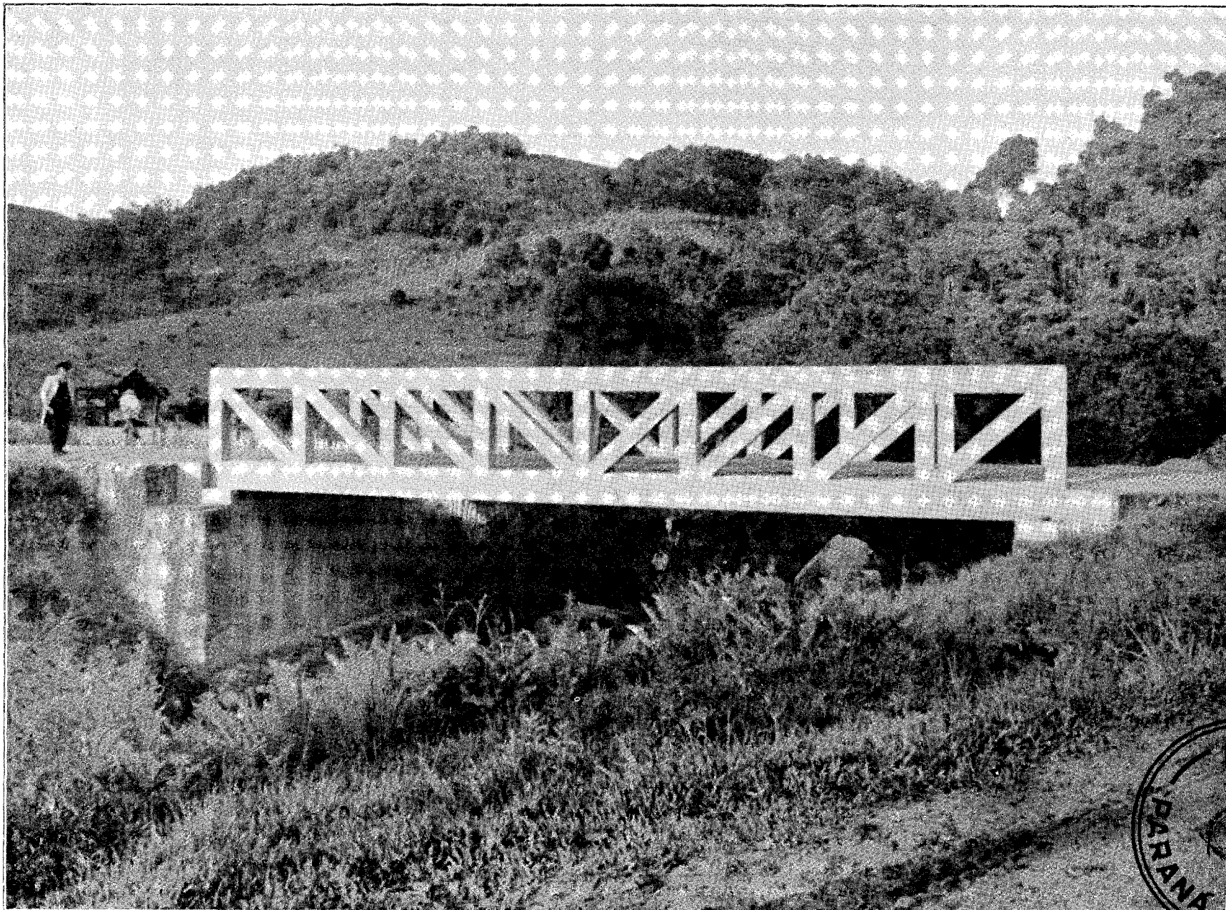
PONTE SÔBRE O RIO "TAQUARÍ" - GRACIOSA
