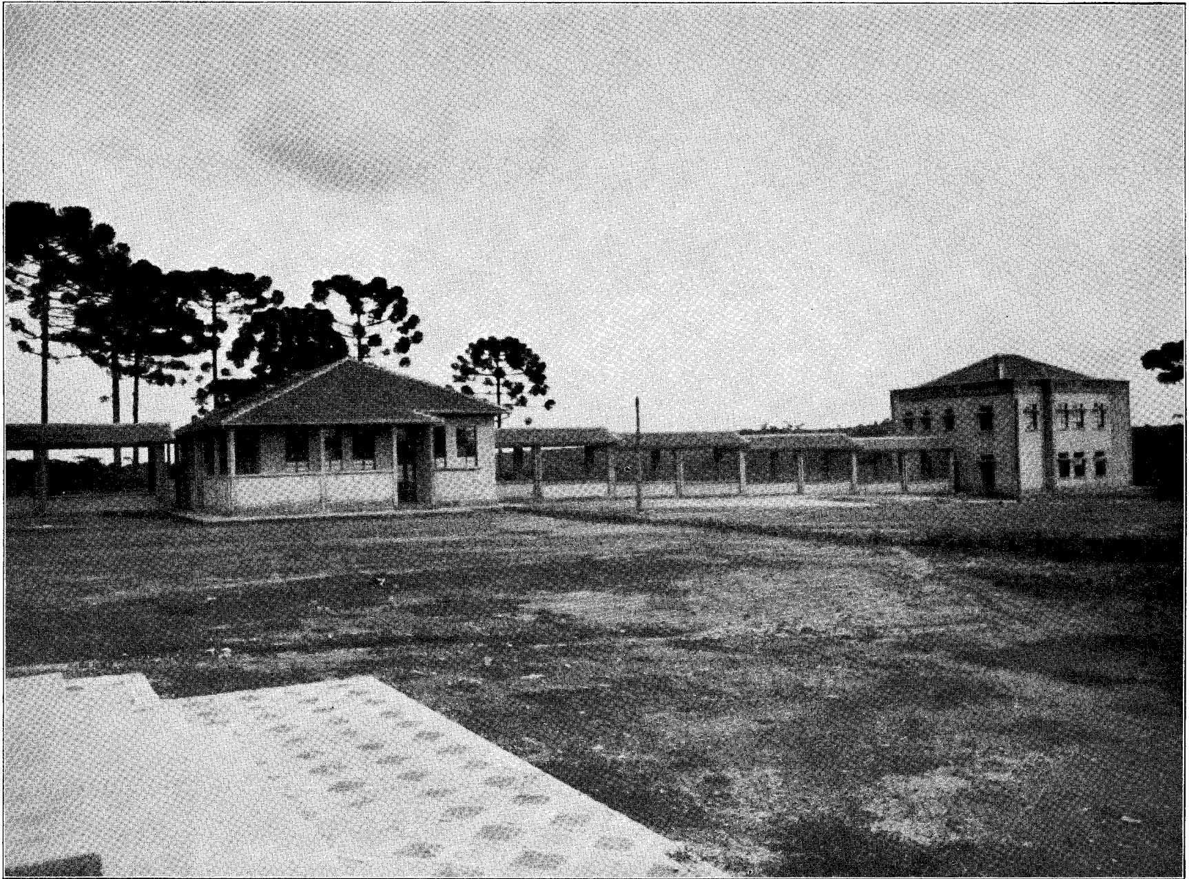
CONSTRUÇÕES DIVERSAS - (Leprosário São Roque) - PIRAQUARA
