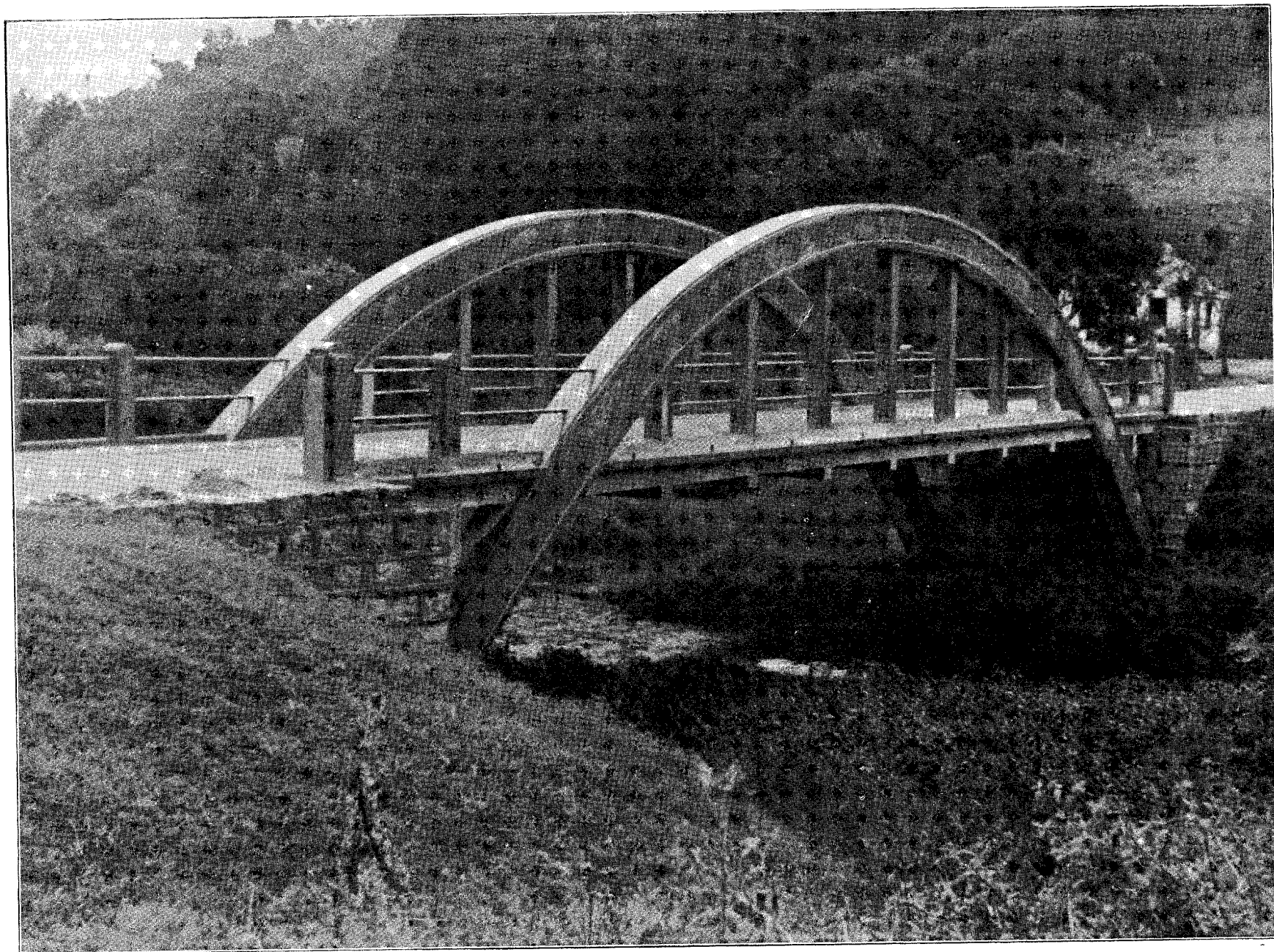
Ponte em concreto armado sobre o Rio "Capivari" - Estrada "Curitiba-Antonina"
