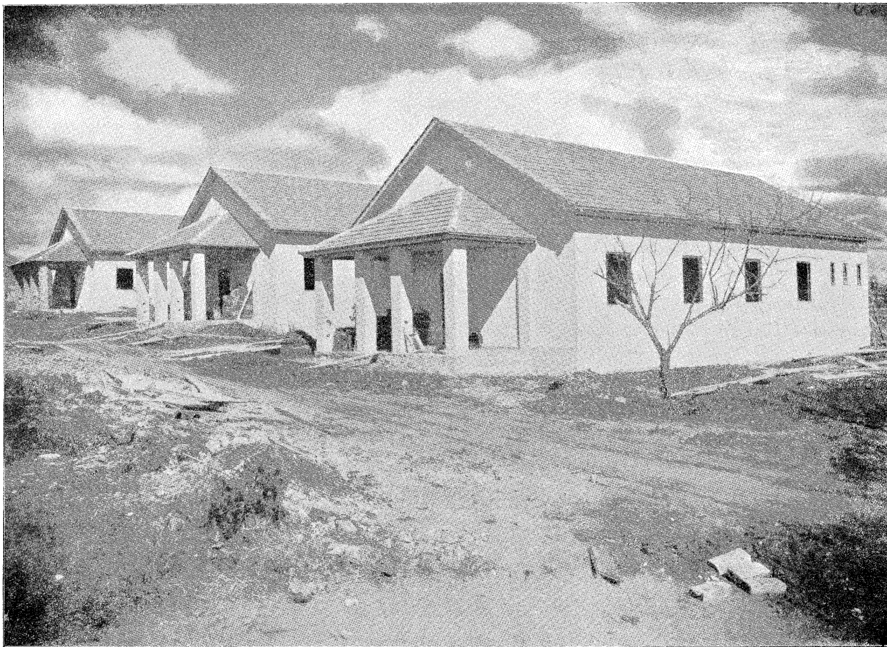
Fotografia de novas edificações que estão sendo construídas no Leprosário São Roque
