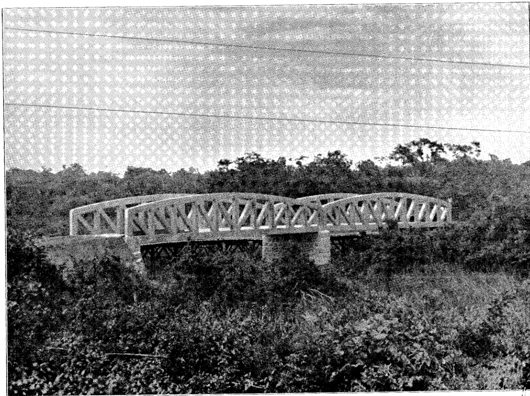
Ponte em concreto armado sôbre o Ribeirão Vermelho - Estrada "Curitiba-Paranaguá"
