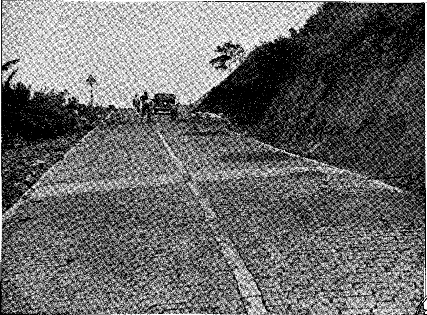
ESTRADA CURITIBA—ANTONINA (Serra do Mar). Revestimento a paralelepípedos
