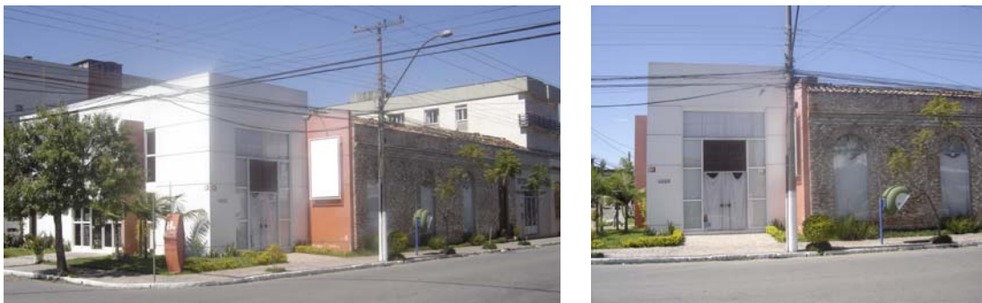
Figuras 80 e 81 – Linguagem dos materiais, alvenaria descascada e novo volume construído Fonte: acervo próprio, 2006
