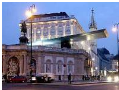
Figura 33: cobertura de acesso do museu Albertina por Hans Hollein
