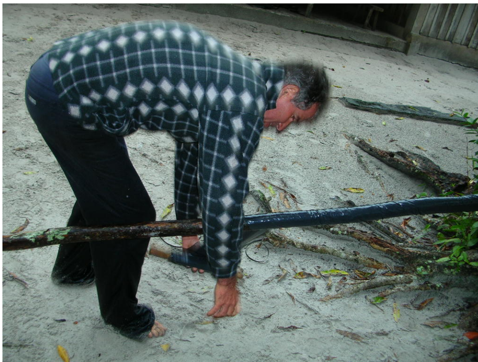
Figura 18: Cerqueiro realizando a plastificação de um mourão. (Foto: Flavia C. de Oliveira).
