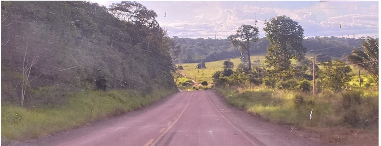
Figura 04: Trecho asfaltado da BR-163, Planalto Santareno, Pará.
