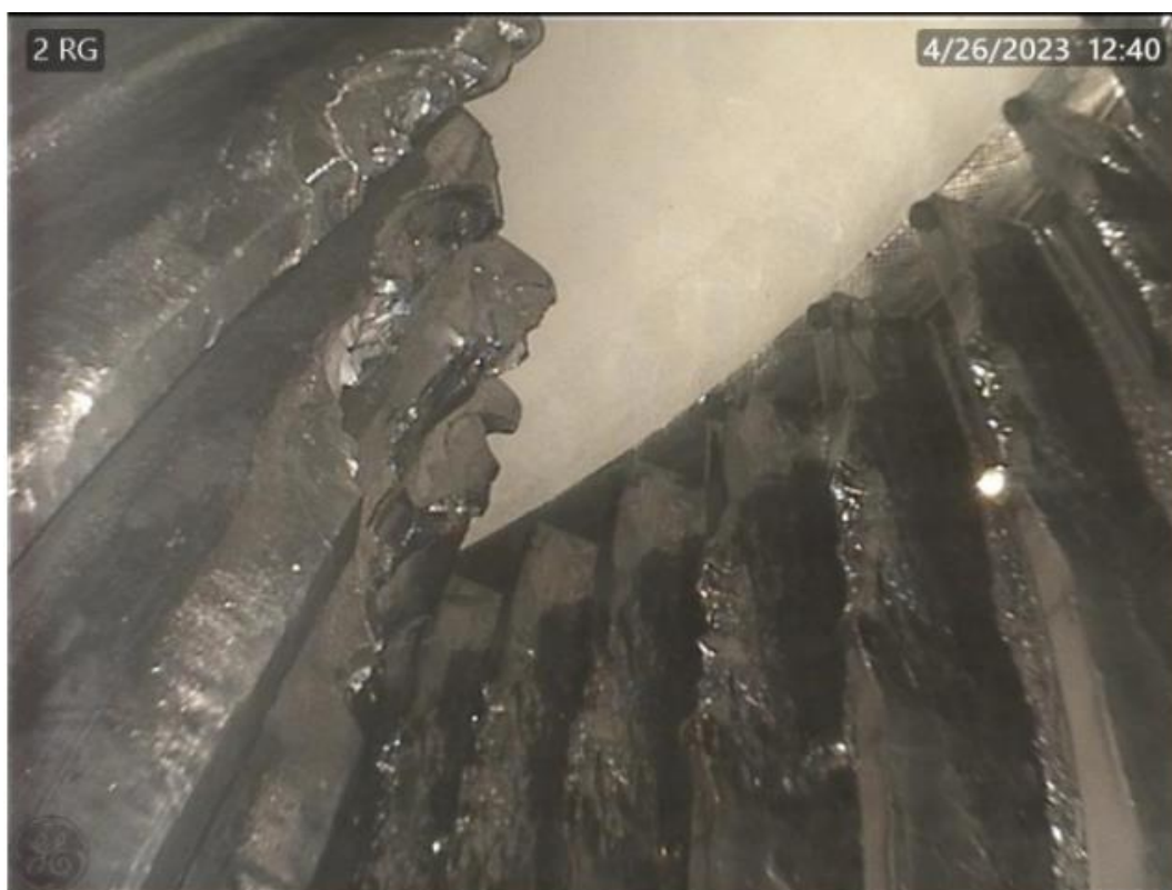
Figura 24: Par de engrenagens fraturadas
