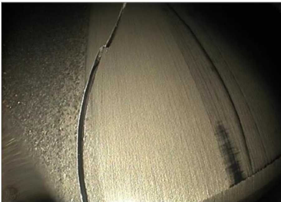
Figura 26: Trinca em dente por falha de fabricação
