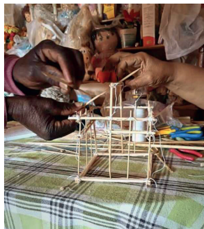
Figura 3: Maqueta esquemática de armado del bahareque. Fuente: elaborado por los autores.
