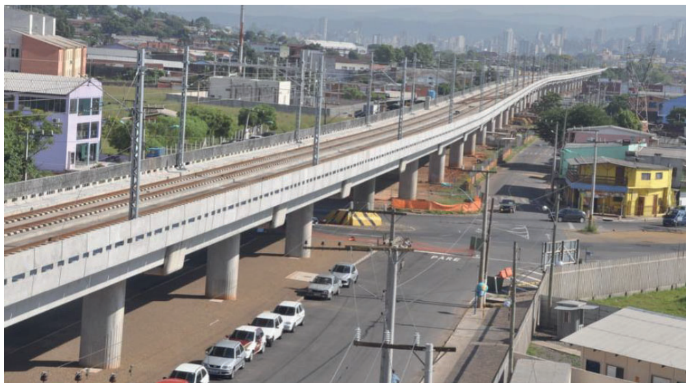
Figura 4: Linha 1 do Trensurb elevada em Novo Hamburgo/RS. Fonte: Trensurb (2012).
