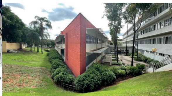
Figura 4: Vistas das fachadas sudeste e sudoeste. Figura 5: Vistas das fachadas sudeste e norte e da passarela de ligação à Escola de Engenharia. Fonte: Autores.
