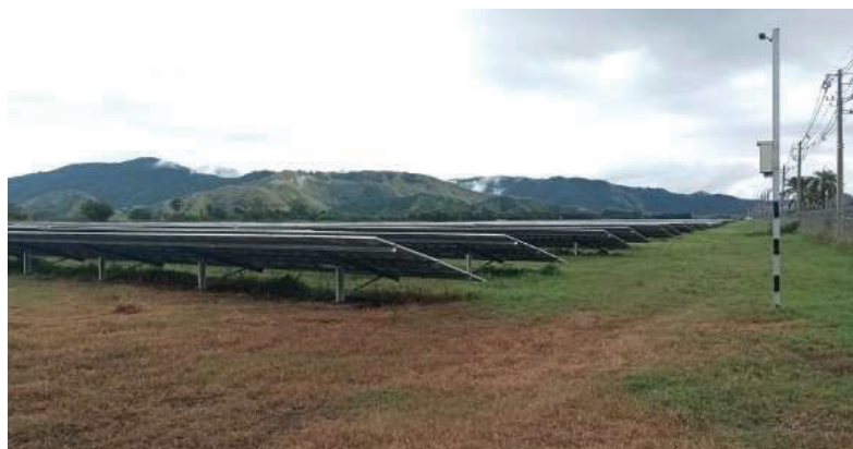
Figura 3. Usina solar fotovoltaica auditada.
