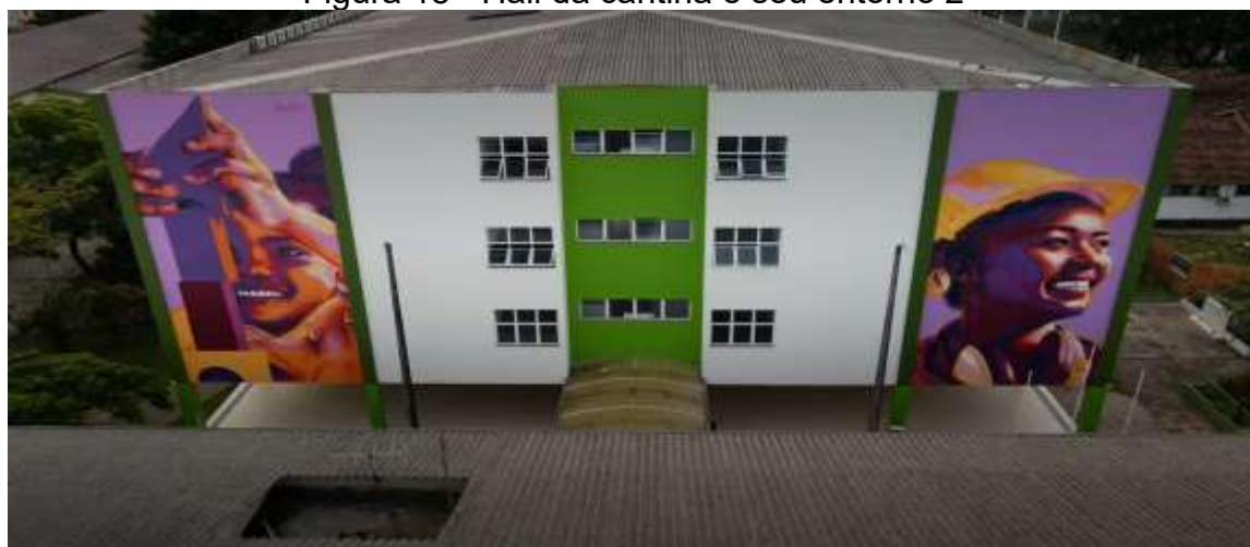
Figura 18 - Hall da cantina e seu entorno 2
