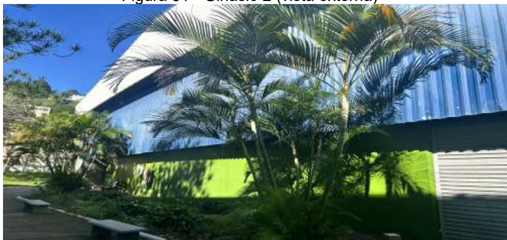
Figura 31 - Ginásio 2 (vista externa)
