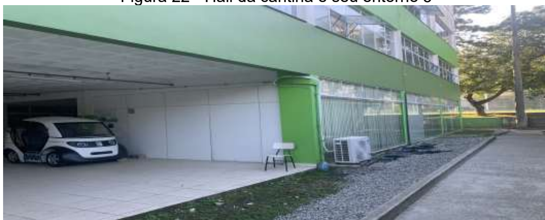
Figura 22 - Hall da cantina e seu entorno 5
