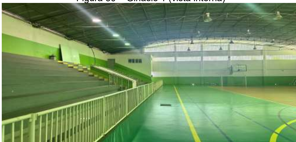
Figura 30 – Ginásio 1 (vista interna)
