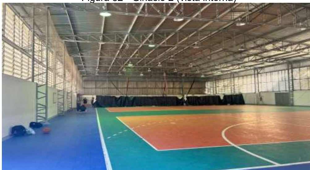
Figura 32 - Ginásio 2 (vista interna)
