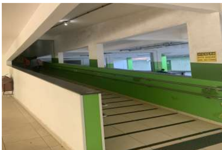
Figura 23 - Rampa de acesso ao Bloco Central
