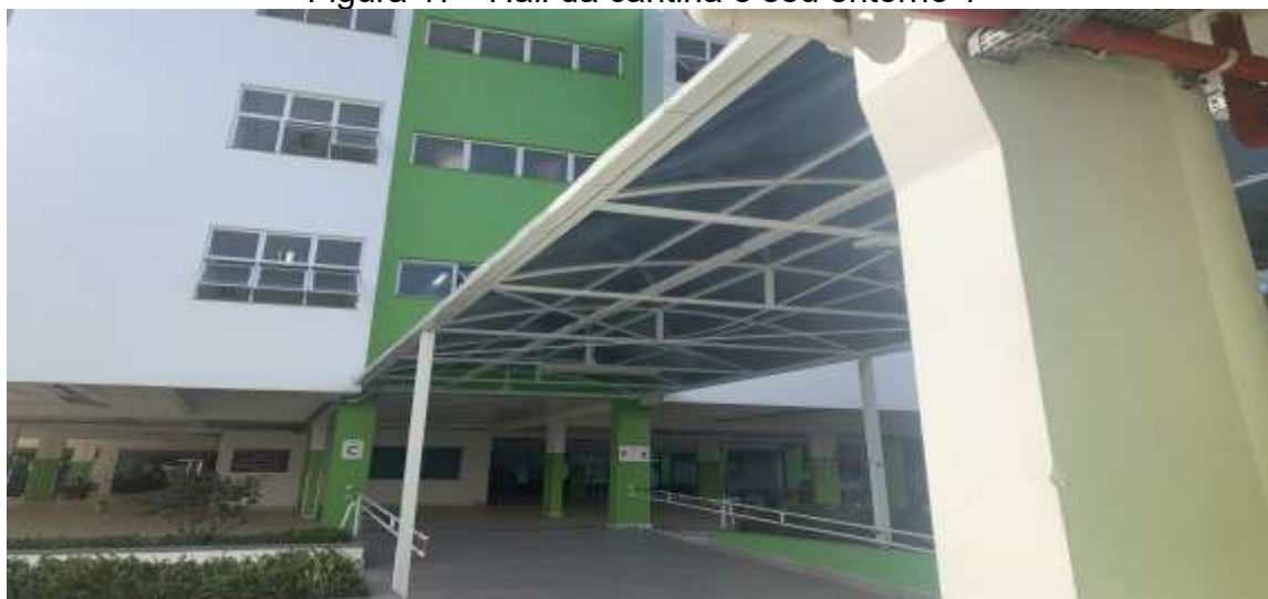
Figura 17 - Hall da cantina e seu entorno 1
