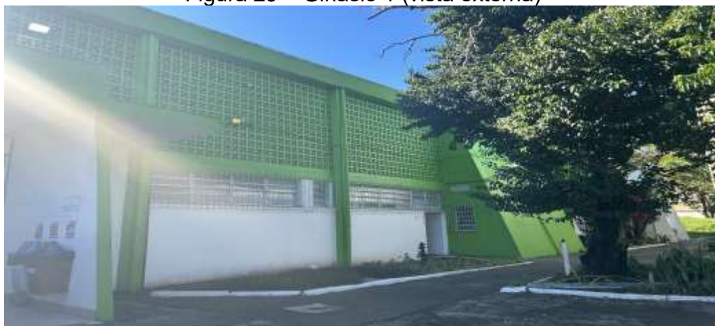
Figura 29 – Ginásio 1 (vista externa)
