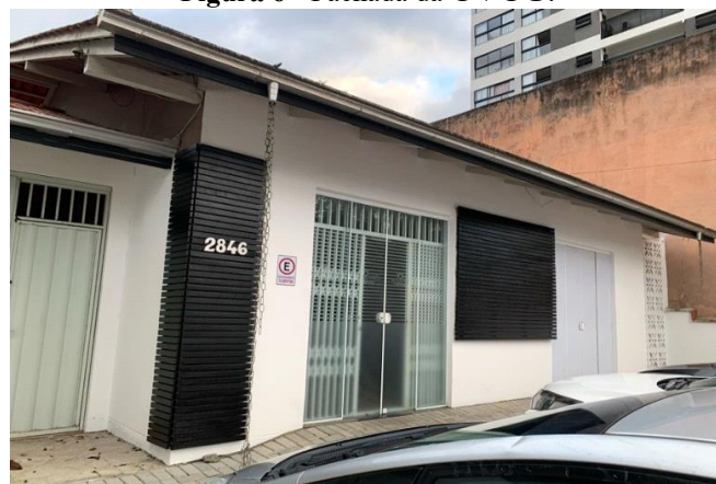
Figura 6 - Fachada da CVCG.
