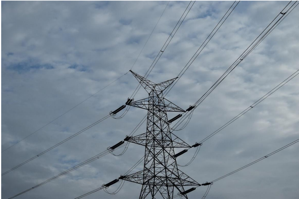
Figura 6 - Estrutura em ângulo
