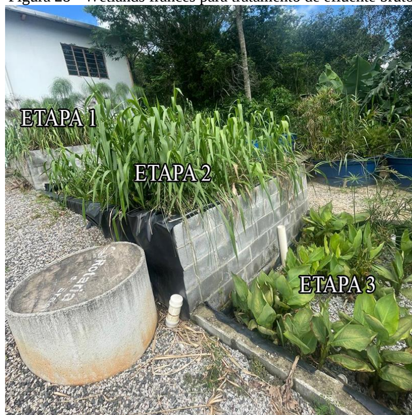
Figura 28 - Wetlands francês para tratamento de efluente bruto
