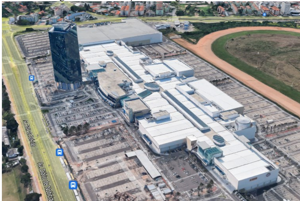
Figura 13 – Edificação em imagem de satélite 3D.
