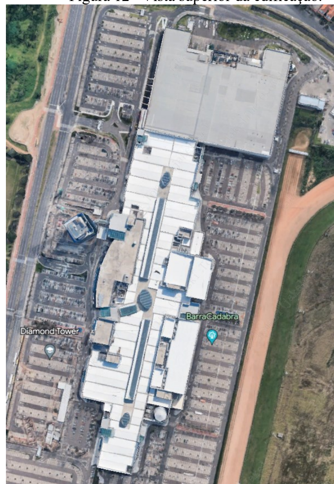
Figura 12 – Vista superior da edificação.
