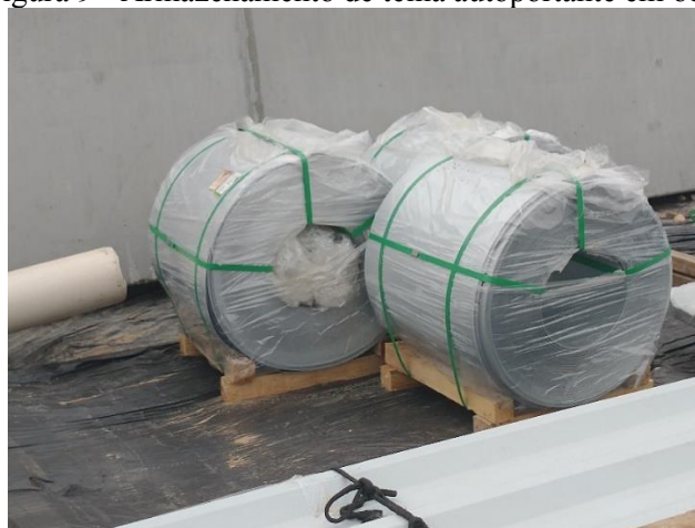
Figura 9 - Armazenamento de telha autoportante em obra
