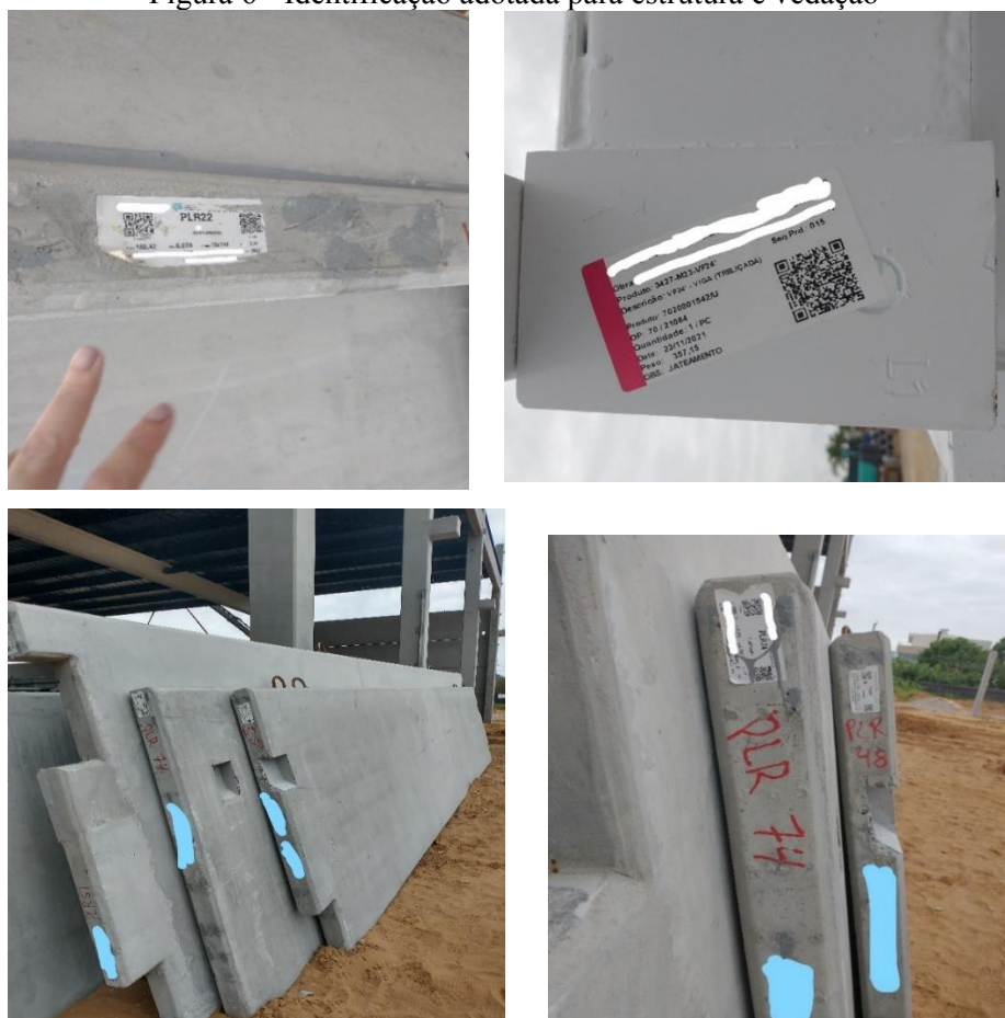
Figura 6 - Identificação adotada para estrutura e vedação
