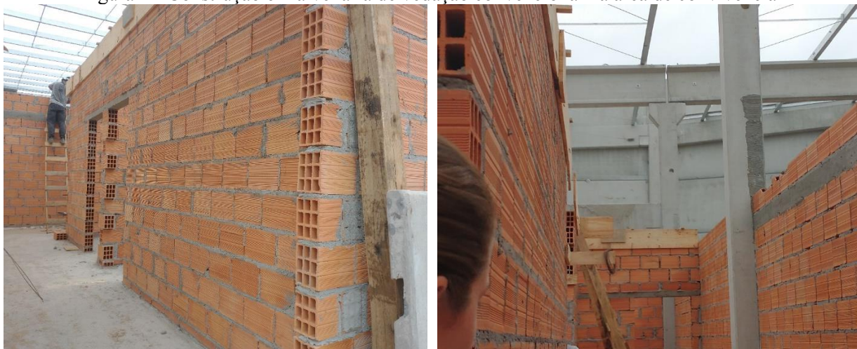
Figura 4 - Construção em alvenaria de vedação convencional na área de convivência
