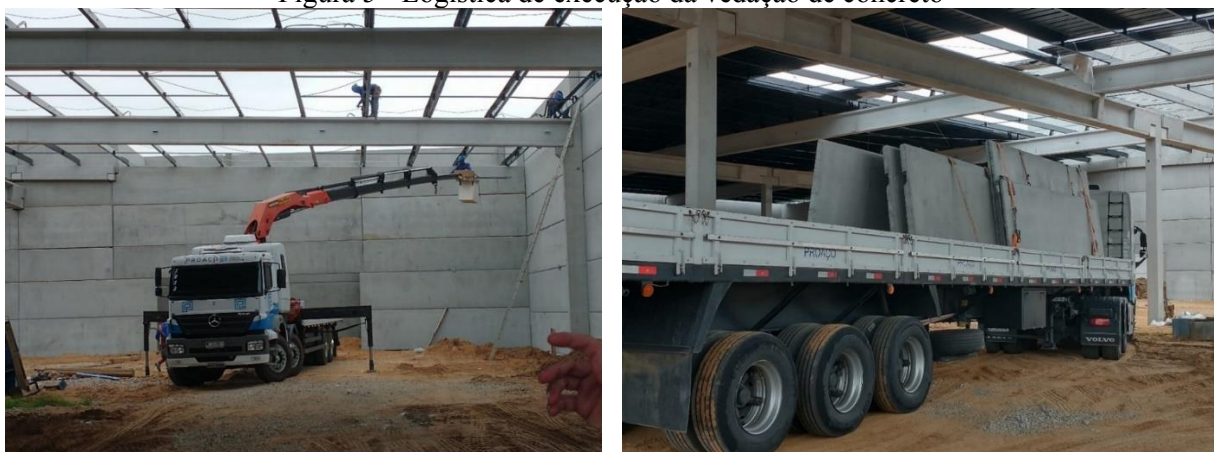
Figura 5 - Logística de execução da vedação de concreto
