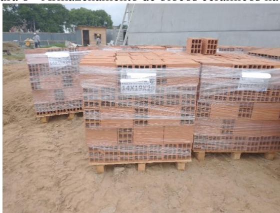
Figura 8 - Armazenamento de blocos cerâmicos na obra
