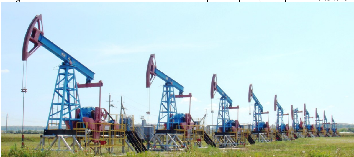
Figura 2 – Unidades bombeadoras terrestres em campo de exploração de petróleo onshore .
