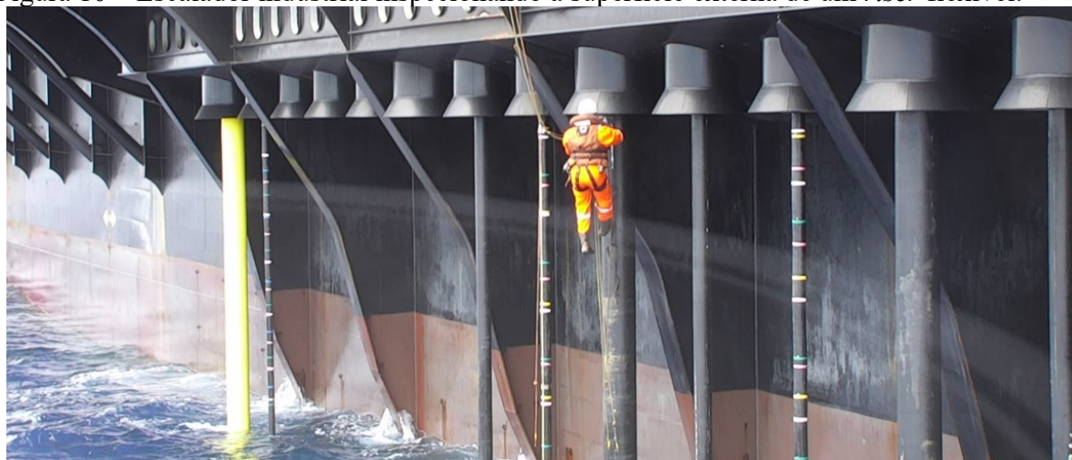
Figura 10 – Escalador industrial inspecionando a superfície externa de um riser flexível.
