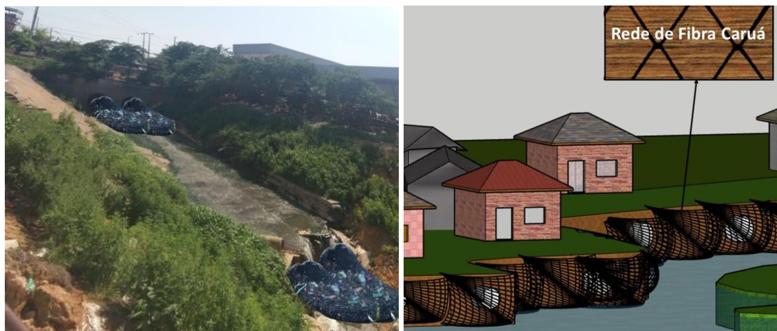
Figuras 9 e 10: Protótipos das redes para coleta de resíduos grosseiros presentes no esgoto. Fonte: autores.
