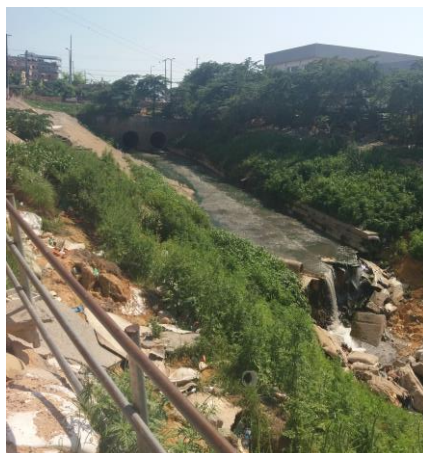
Figura 8: Situação do canal na saída da ETE do Quarenta. Fonte: Autores.
