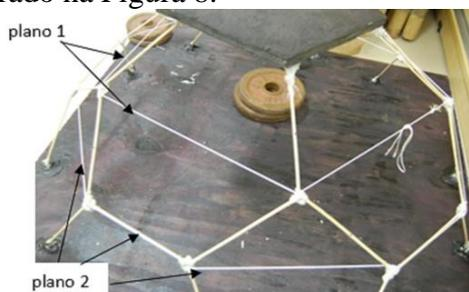
Figura 8: Detalhes dos planos de amarração dos cabos de nylon na estrutura geodésica de bambu.
