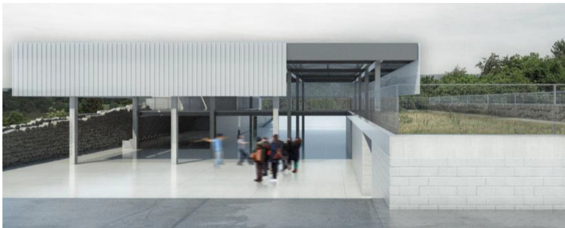
Figura 14: Acesso a edificação e Cobertura verde experimental. Fonte: Elaborada pelos autores.
