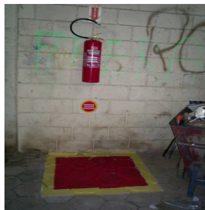
Figura 12 – Unidade extintora com agente extintor de água para combate de fogo classe A
