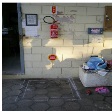
Figura 10 – Instalação de extintor
